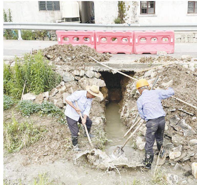
施工人员正在疏通沟渠。
