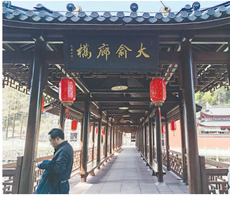
大俞村大俞溪上新建的廊桥。
