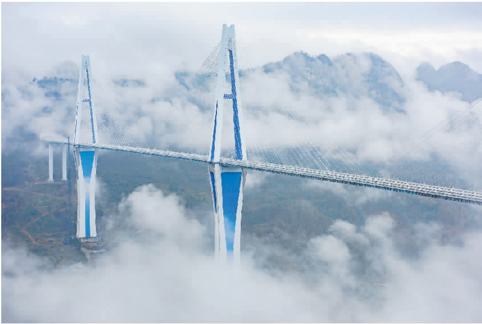
这是平塘特大桥通车现场（2019年12月30日摄，无人机照片）。 新华社记者 刘续摄
