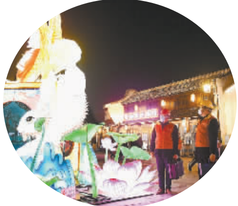
▲2月1日晚，市供电公司阳明供电所工作人员来到阳明古镇民俗灯会现场，对景区内涉及的线路、配电箱等再次进行检查，确保元宵灯展期间供电安全。 记者 黄静波摄
